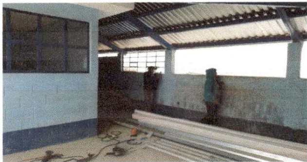
Foto 9: mano de obra especializada
