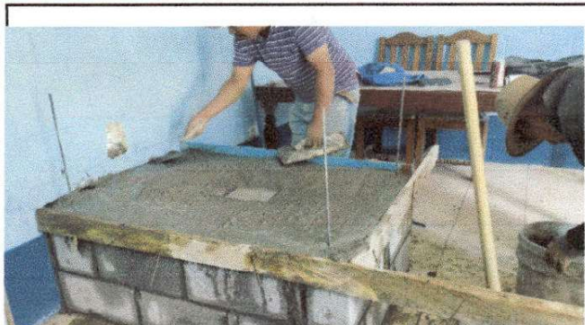
Foto 7: reparación de cocina
