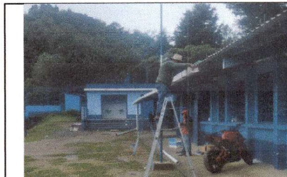
Foto 4: canales y bajadas de agua
